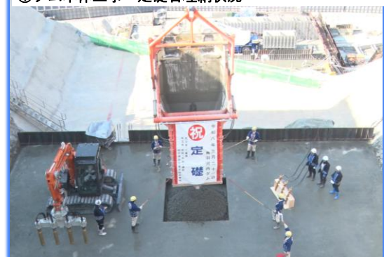
①ダム本体工事 定礎石埋納状況
