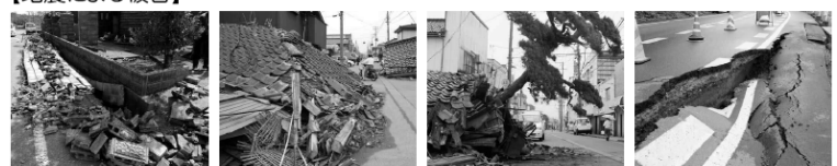
【地震による被害】
