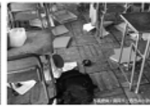
ガラスが散乱した教室
