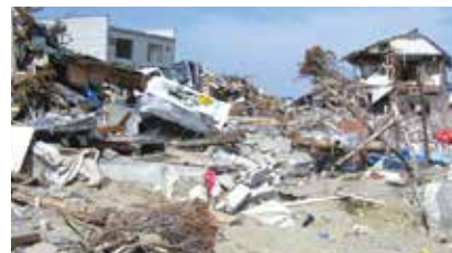
被破坏的住宅街区
