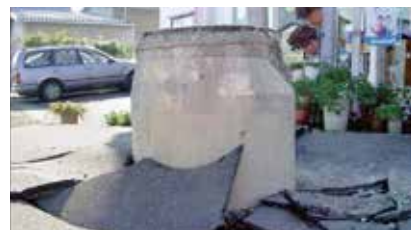
穿出地面的下水管道
