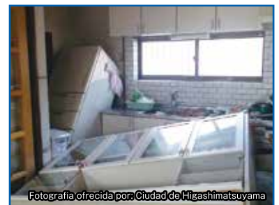
Fotografía ofrecida por: Ciudad de Higashimatsuyama
