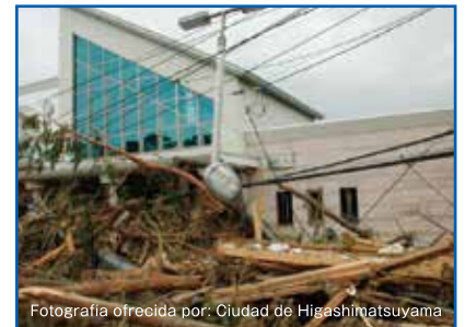
Fotografía ofrecida por: Ciudad de Higashimatsuyama
