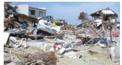
Conjunto residencial destruído
