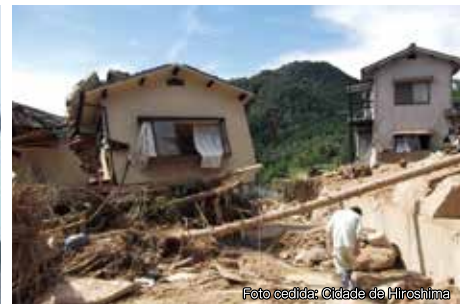
Deslizamento de terra
