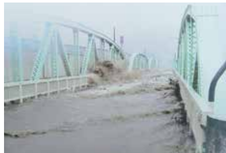
O rio transbordando de tão cheio
