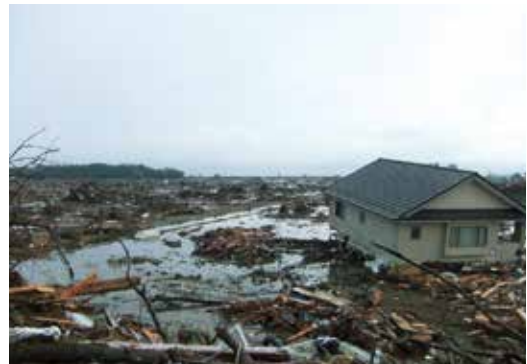
東日本大震災の被害
