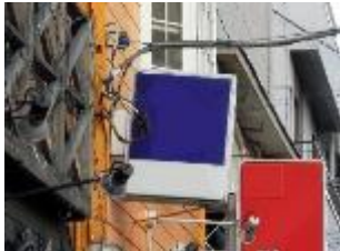
上部構造全体が傾斜した状態
