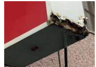
広告板底部の腐食が進行した状態
