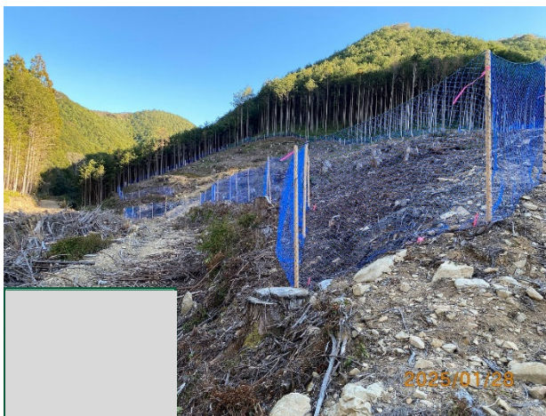
獣害防護柵設置の様子（紀北町）
