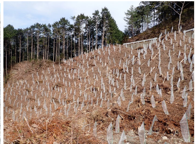
防護チューブ設置の様子（松阪市）
