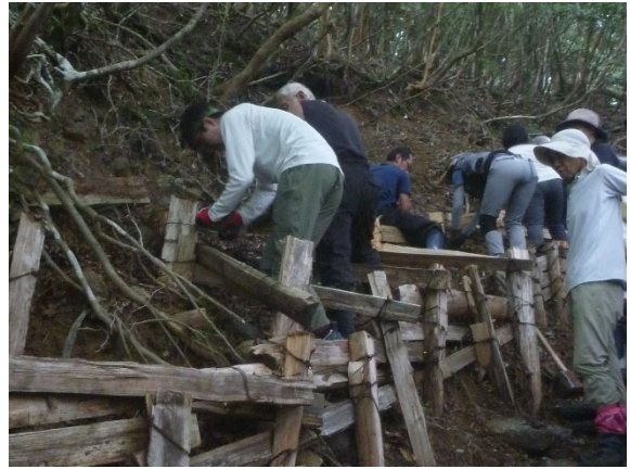
自然観察ツアー&ボランティア整備 (R7. 8. 23~24) 【大杉谷登山歩道】 参加者による歩道整備
