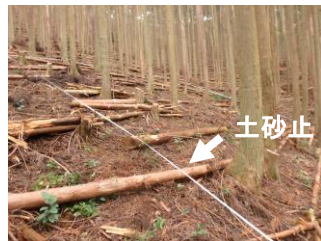
伐倒木を利用した土砂止の設置
