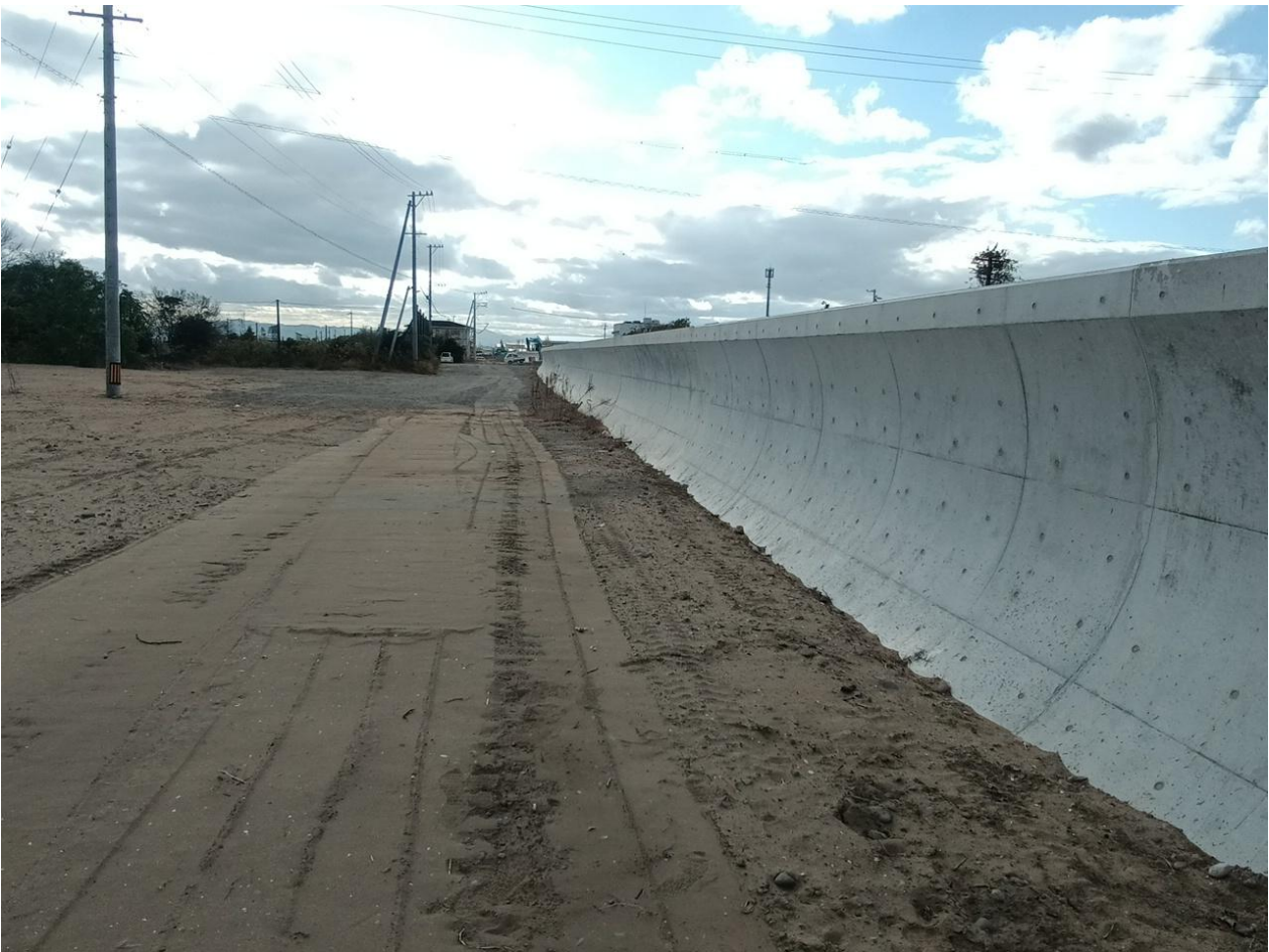
白塚漁港海岸における海岸堤防の耐震・高潮対策
