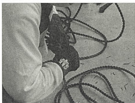
(釘抜き作業の様子)
