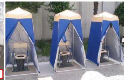
マンホールトイレの整備事例
