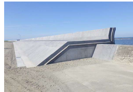
宇治山田港海岸(伊勢市) 海岸堤防の嵩上げと粘り強い構造化
