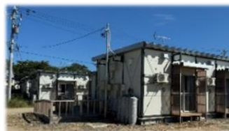
応急仮設住宅
