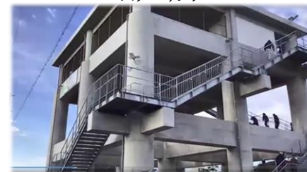
津波避難タワー（志摩市）
