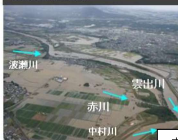
洪水時の浸水状況
