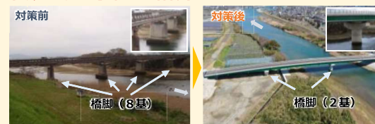
一般県道香良洲公園島貫線 香良洲橋
