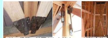
柱・梁等に設置された筋交い・補強金物
