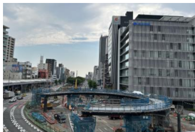
円形デッキ工事状況写真
