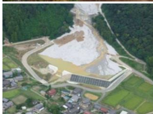
土石流 補足後
