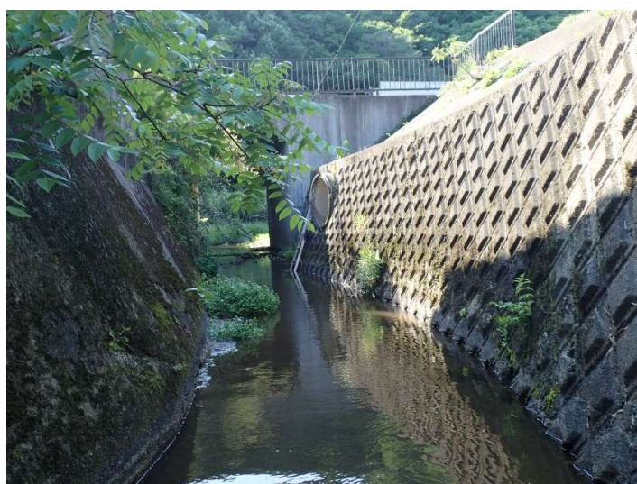
写真 4-3 調査地点 W3 の状況（令和 5 年 5 月 11 日）
