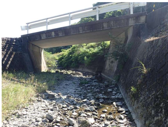
写真 4-1 調査地点 W1 の状況（令和 5 年 5 月 11 日）
