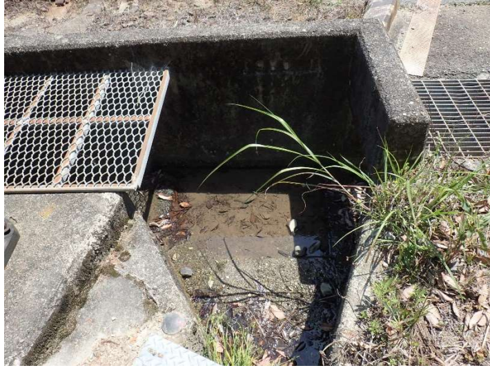
写真 4-4 調査地点 W4 の状況 (令和 5 年 5 月 11 日)
