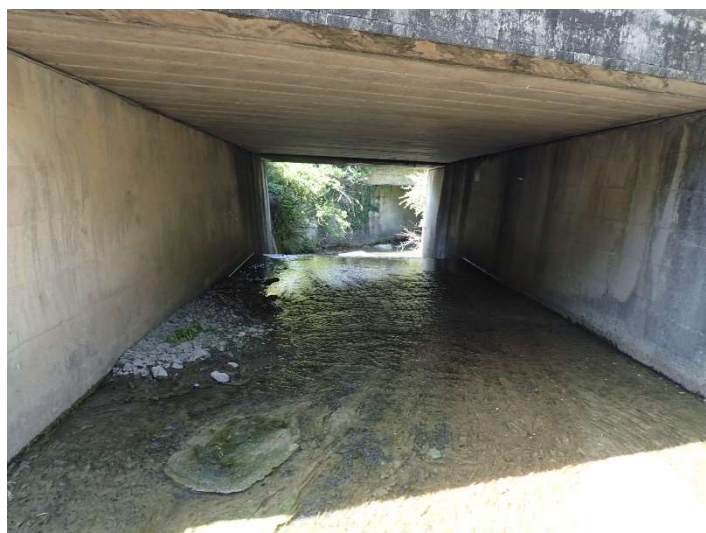
写真 4-2 調査地点 W2 の状況（令和 5 年 5 月 11 日）
