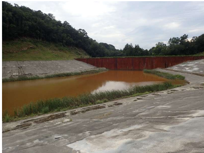
写真 1-8 【残存個体確認調査】アカハライモリ、トノサマガエルが確認された調整池 （消失した移植地 A、B に隣接：令和5年8月17日）
