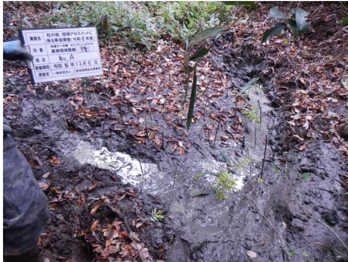
写真 2-4-1 移殖地整備状況(水路整備状況) 移殖地No. A 令和5年12月5日
