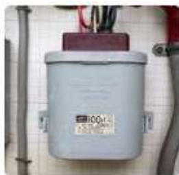
低圧コンデンサー (分電盤に内蔵)
