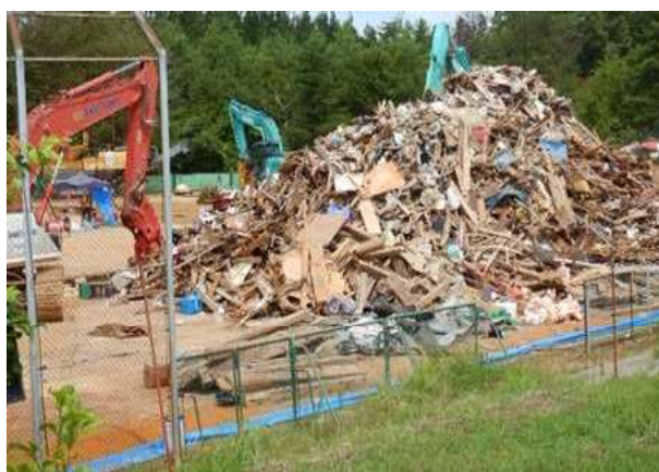
写真4 令和6年能登半島地震における輪島市第一仮置場
