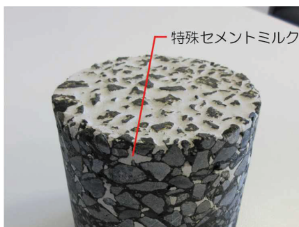
付図 1.2.4.1 半たわみ性舗装のコアの事例
