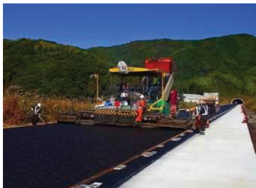
付図 1.1.3.1 コンポジット舗装の施工状況
