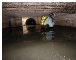
滞水した溝橋内部の目視点検
