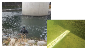
潜水調査による河床洗掘の把握
