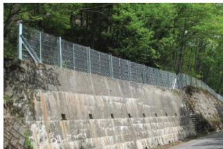
<落石防止柵の取替>
