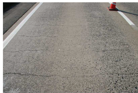
付図 1.1.2.2 供用中の連続鉄筋コンクリート舗装
