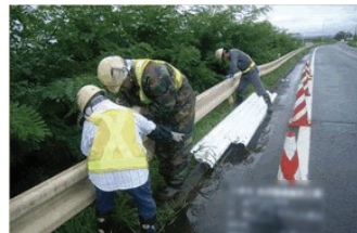
<防護柵の取替>
