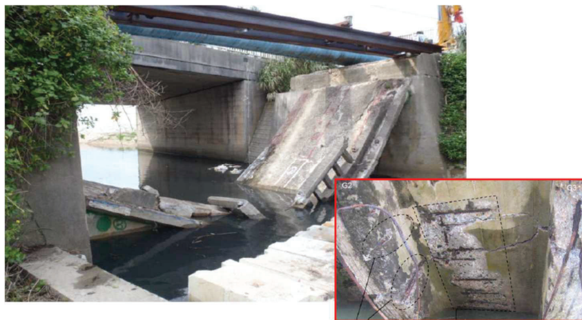
写真 2-1 老朽化が原因で落橋した国内事例
