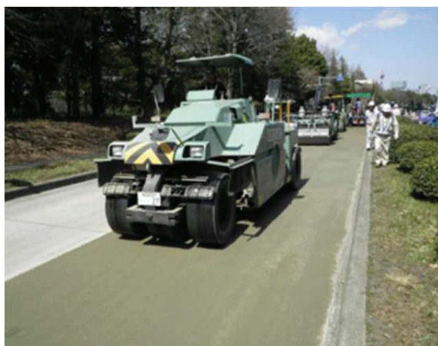
付図 1.1.4.1 施工中の転圧コンクリート舗装
