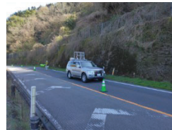
MMS※1を活用した 斜面・のり面点検
