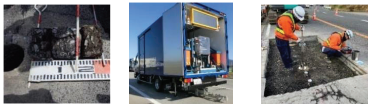
【コア抜き調査】 【FWDたわみ量調査】 【開削調査】
