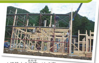
▲建設中の尾鷲ヒノキの家
