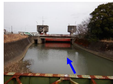
神内川防潮水門の現況
