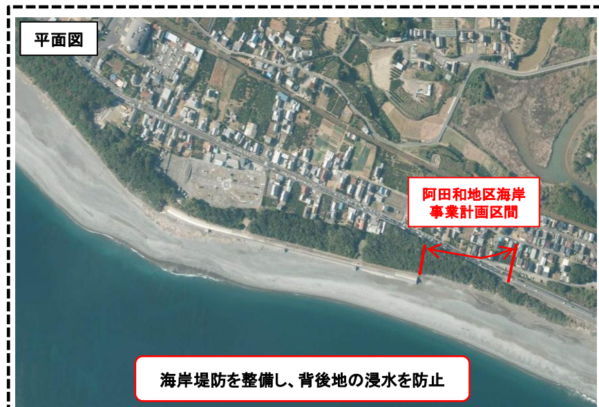
整備状況 (堤防整備)
