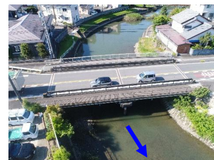
波静橋の現況
