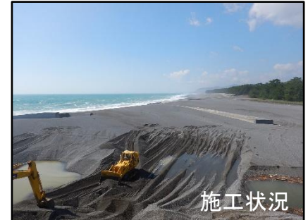
河口開削（志原川） 【御浜町】
