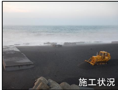
河口開削（志原川） 【御浜町】
