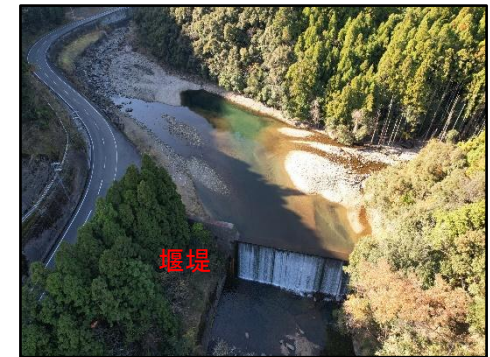
砂防堰堤堆積土砂撤去
