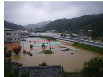
紀伊半島大水害浸水被害状況
