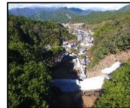
砂防堰堤の整備(猿谷) 【三重県】
