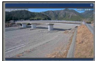
簡易型河川監視カメラ
