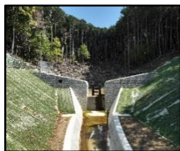
砂防堰堤の整備(名柄川支川1) 【三重県】
