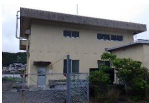
山本地区排水機場 (排水機場整備)【三重県】
