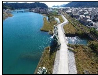
堤防強化事業(船津川) 【三重県】
