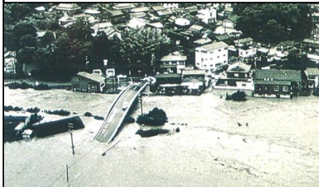
平成27年9月豪雨時浸水状況
