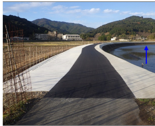
押淵川における護岸整備（堤防強化） （左：施工前 右：施工後） （三重県）
