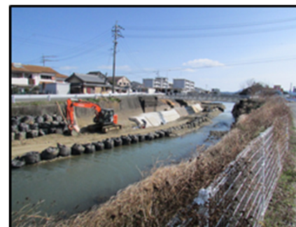
外城田川河道掘削 （玉城町）
