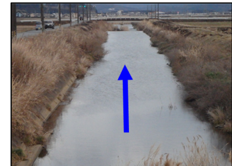
外城田川河道掘削 （多気町）
