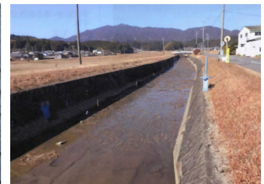
津市内河川における河道掘削 （津市）
