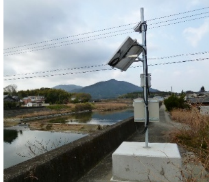
簡易型河川監視カメラ （三重県）
