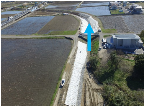
三泗川における護岸整備 （三重県）
