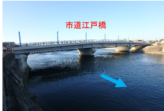
志登茂川における橋梁改築 （三重県）
