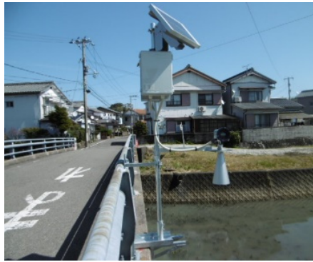
危機管理型水位計 （三重県）
