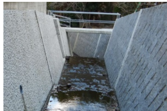
津市内河川における河道拡幅 （津市）
