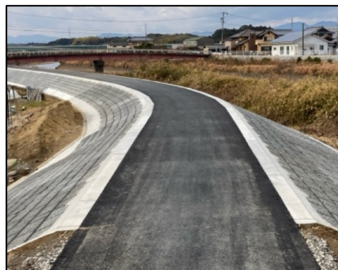
中ノ川における堤防補強 （三重県）
