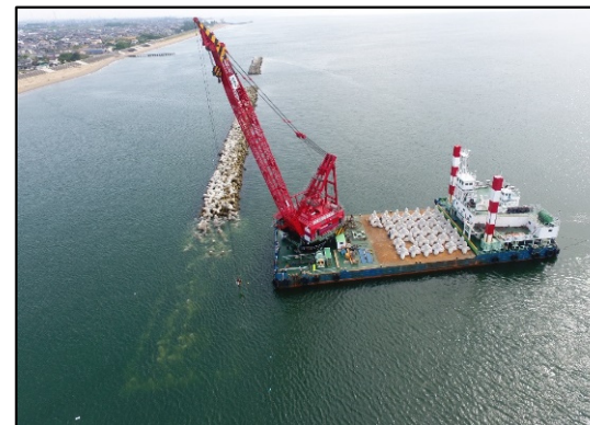
南若松海岸における離岸堤整備 （三重県）
