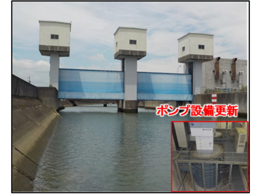
堀切川排水機場延命化対策事業 （ポンプ設備更新）（三重県）
