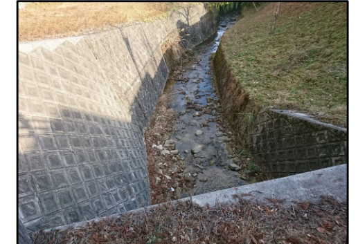
雲田川における浚渫 （菟野町）
