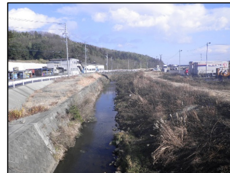
朝明新川における河川整備 （四日市市）
