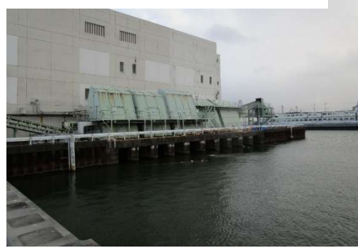
【川越町】川越排水機場ストックマネジメント事業
