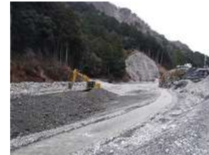
砂防堆積土砂撤去事業 (三重県)
