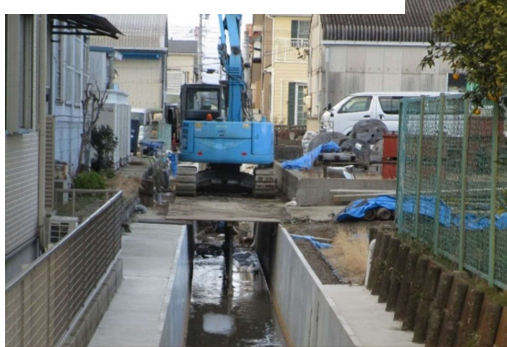
【川越町】下水道（雨水）施設整備事業
