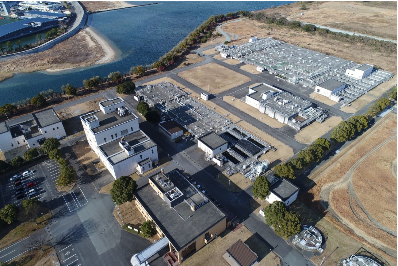
雲出川左岸浄化センター
