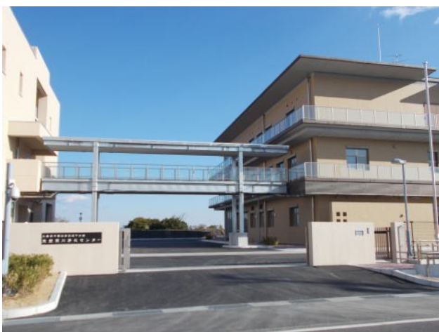
志登茂川浄化センター
