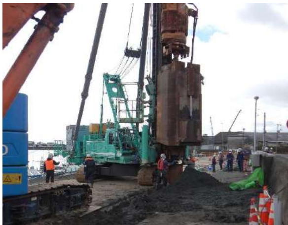
津松阪港 新堀地区 物揚場改良 施工状況
