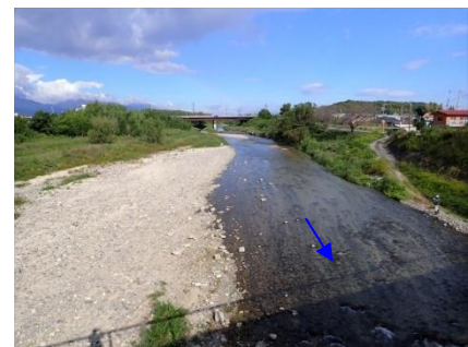
高角橋より上流
