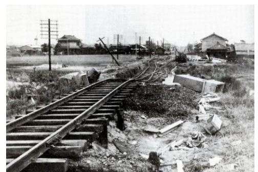
とみだはま 関西線富田浜駅路敷 （「四日市市史」より）
