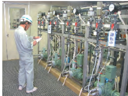
薬品注入設備の定期点検
