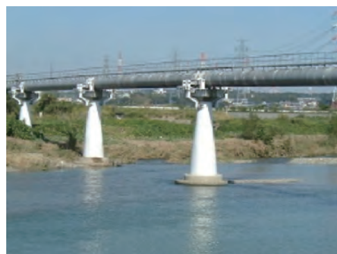
耐震補強後の員弁川水管橋
