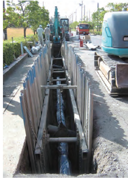
送水管布設工事(イメージ写真)
