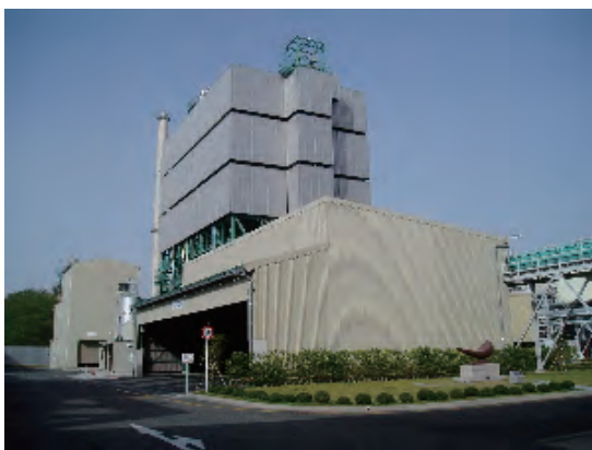
三重ごみ固形燃料発電所
