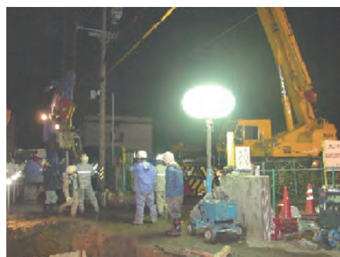
夜間の漏水復旧作業
