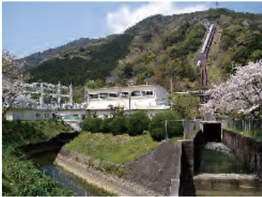
宮川第二発電所(水路式)
