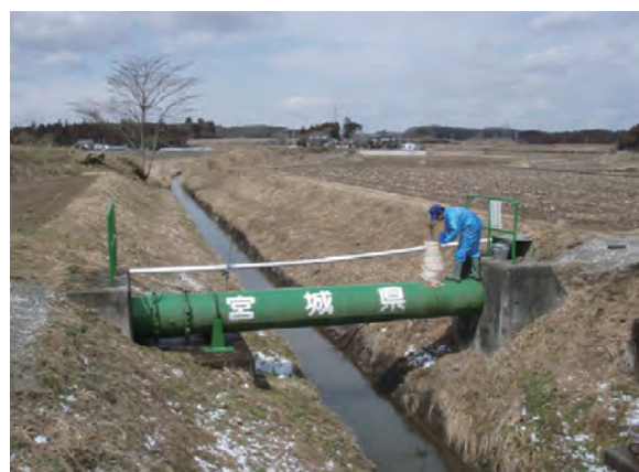
【工業用水道施設・管路の点検】
