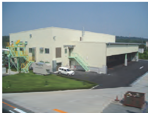
RDF貯蔵施設
