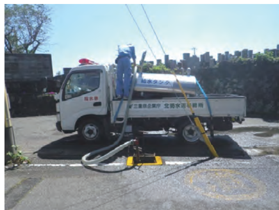
【給水車への補給作業(紀宝町)】
