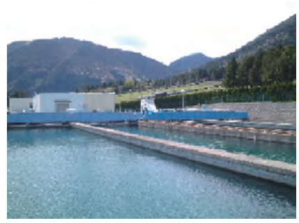
沈でん池(北中勢水道 水沢浄水場)
