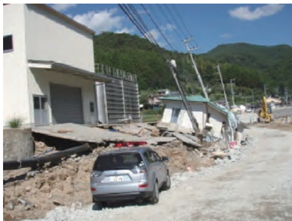
【浄水施設の被災状況(熊野市)】
