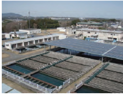
浄水場(北中勢水道 高野浄水場)
