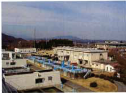
浄水場（北中勢水道 高野浄水場）
