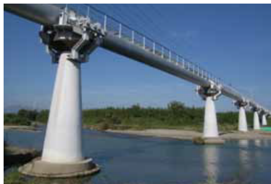
員弁川水管橋
