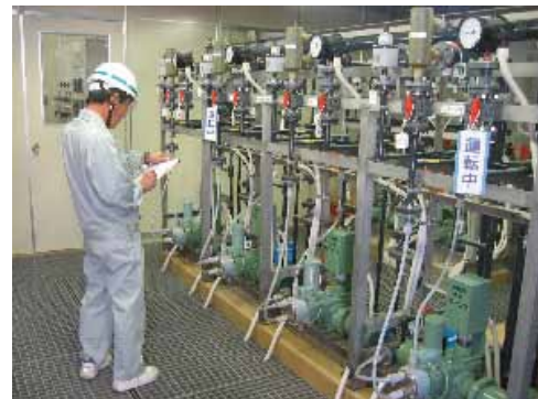
薬品注入設備の定期点検
