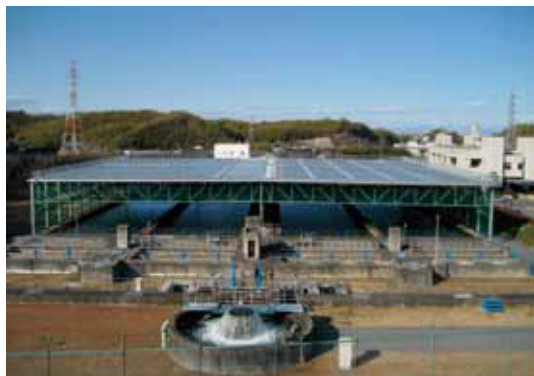
播磨浄水場と太陽光発電設備
