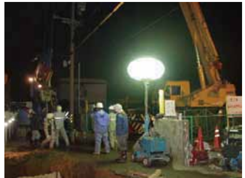
夜間の漏水復旧作業
