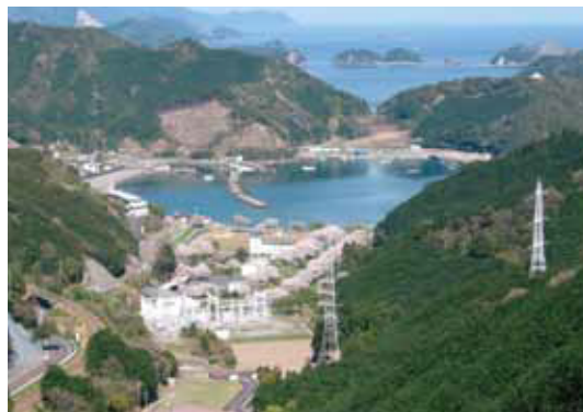
始神峠から見た宮川第二発電所
