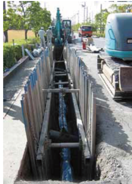
送水管布設工事(イメージ写真)
