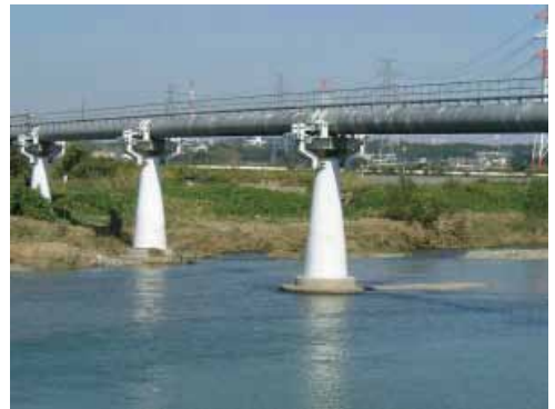
耐震補強後の員弁川水管橋
