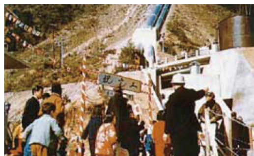
宮川第二発電所完工式
