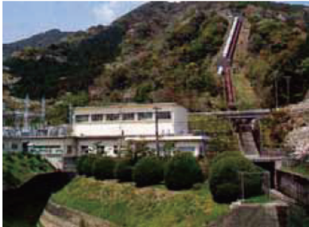
宮川第二発電所(水路式)
